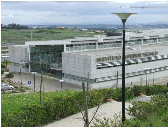
Figura 9 - Edifício do Instituto Superior Técnico
