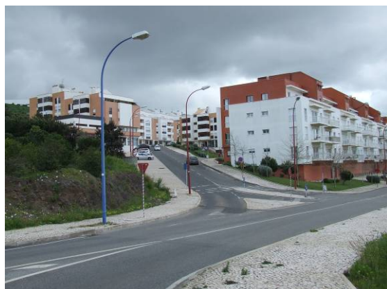
Figura 18 - Habitações plurifamiliares no quadrante sudoeste
